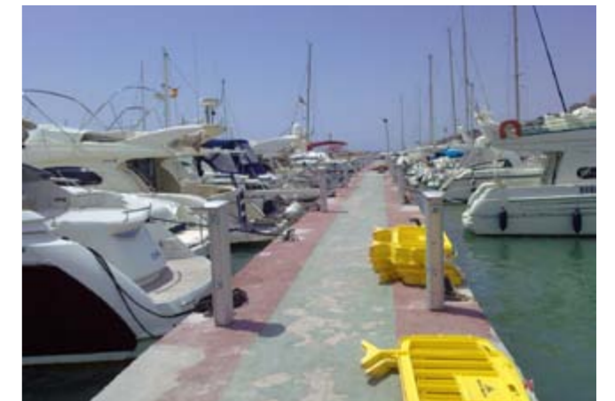
PANTALANES DESPUÉS / PONTOONS AFTER
